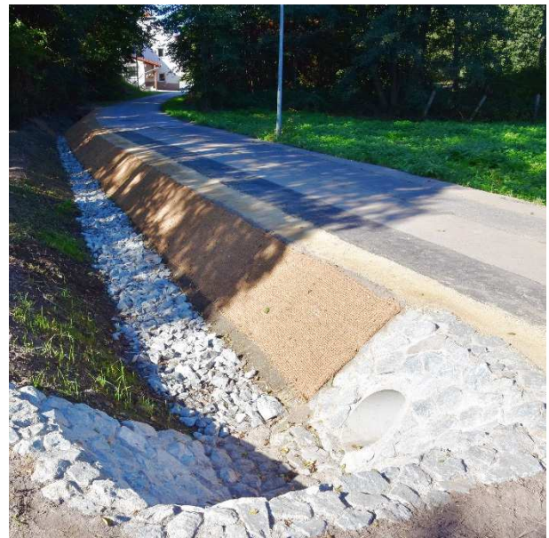
Erneuerung Durchlass am „Kirchweg“
