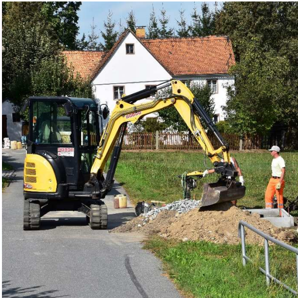
Sanierung der Straße „Am Rosenbach“
