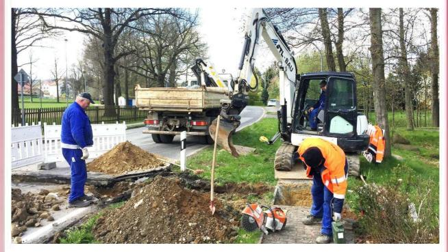
Die Verteilerkästen im gesamten Ort werden zu Mini – Vermittlungsstellen umgebaut. Dazu ist auch ein Elektroanschluss notwendig.
